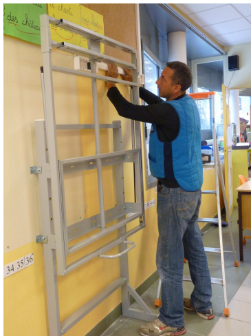
Pose du châssis
