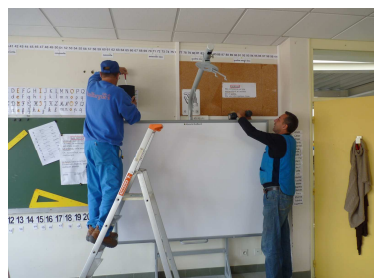
Installation des baffles
